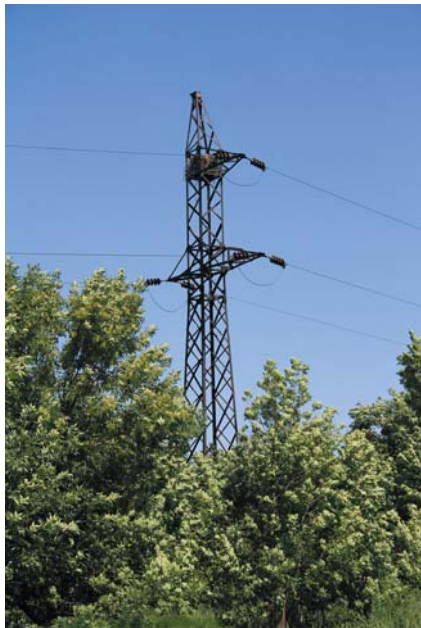
Рис. 3. Гнездо могильника на опоре ЛЭП. 1.07.2012 г.
