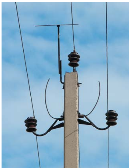
Рис. 5. Птицезащитное устройство из металла, установленное во времена СССР, представляет опасность для птиц и подлежит замене современным диэлектрическим устройством (см. рис. 2).
